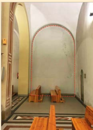
Estat actual. Mòdul 2 parament interior nau lateral Garbí. On anira una obertura.
