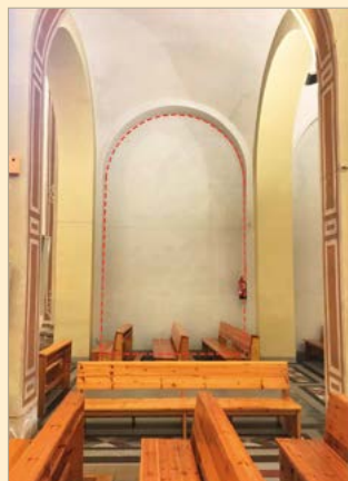
Estat actual. Mòdul 1 parament interior nau lateral Garbí. On anira una obertura.
