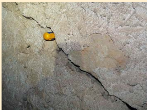
Detall gruix esquerda mur portant del cimbori.
