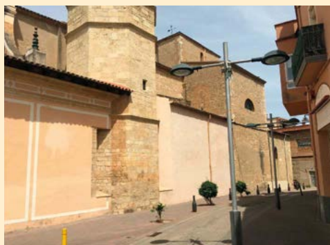
Detall del canvi de cromatisme entre diferents mòduls de la façana garbí, carrer Torras i Bages.
